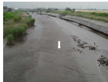
写真 2.3-14 下流部の様子
