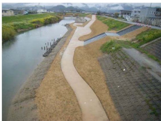
写真 2.1-31 遊歩道(7k000 付近)
