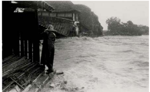
写真 2.2-10 城原川沿岸の民家流出
