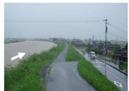
写真 2.3-2 平成22年7月洪水 (新村橋付近)
