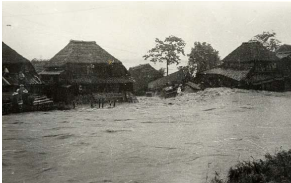
写真 2.2-9 城原川沿岸の民家流出
