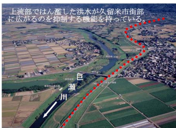
写真 2.2-1 巨瀬川左岸の控堤(久留米市)
