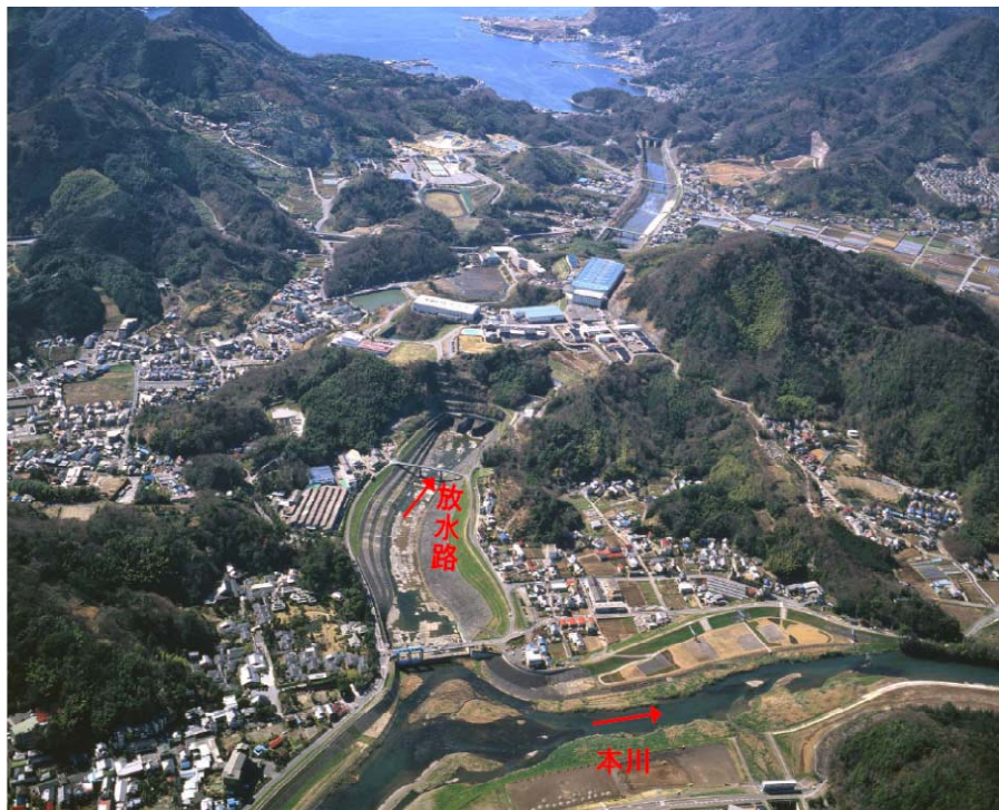
狩野川放水路
