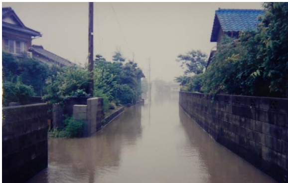
写真 2.2-24 神崎市（旧神埼町）の 浸水状況
