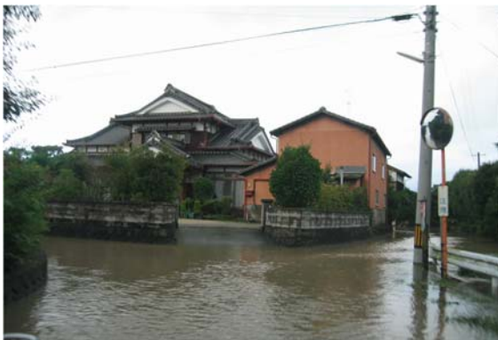
写真 2.2-32 田手川周辺の浸水状況
