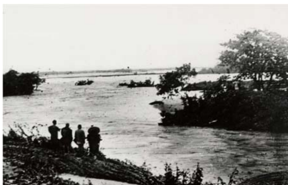
写真 2.2-5 城原川堤防決壊
