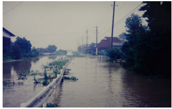
写真 2.2-23 馬場川の氾濫状況
