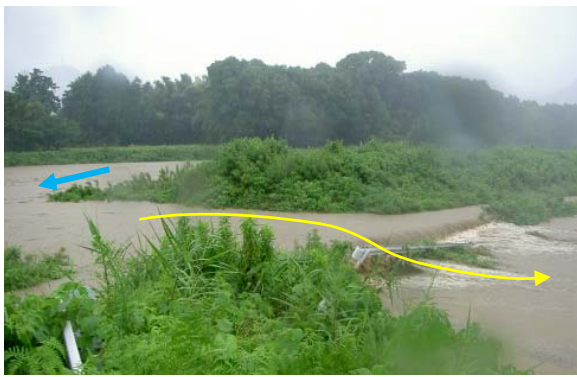
写真 2.2-27 3号野越しからの越水状況
