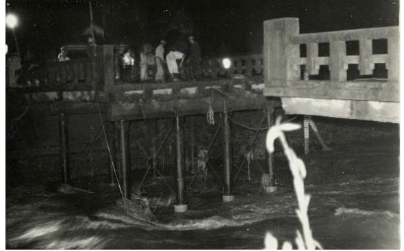
写真 2.2-8 城原川の橋梁流出
