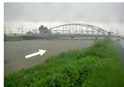
写真 2.3-1 平成21年7月洪水 (神埼橋付近)
