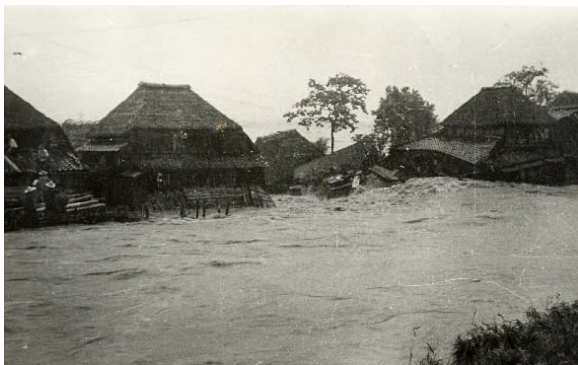
写真 2.2-9 城原川沿岸の民家流出
