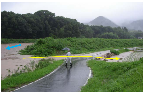
写真 2.2-36 3号野越しからの越水状況
