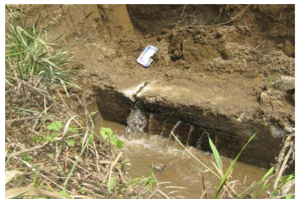
写真 2.3-8 樋管の状況、樋管函体からの漏水
