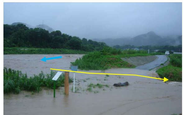
写真 2.2-37 4号野越しからの越水状況
