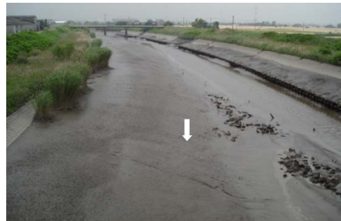
写真 2.1-22 堂地大橋より上流
