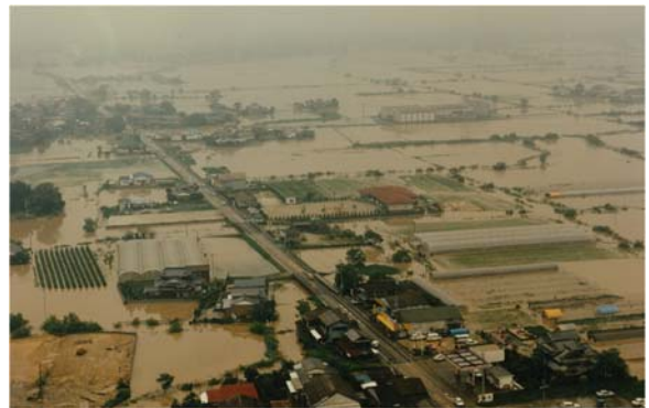
写真 2.2-19 神埼市（旧千代田町）の 浸水状況
