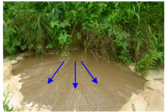
写真 2.3-7 平成 21 年 7 月洪水による堤防川裏法面の崩壊(L=80m)、堤防川裏法尻からの漏水
