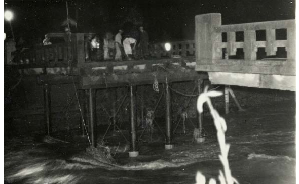
写真 2.2-8 城原川の橋梁流出
