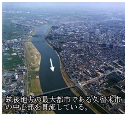
写真 2.1-10 久留米市周辺 (豆津橋付近)
