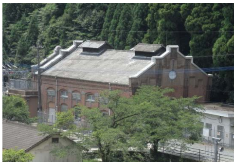
写真 2.2-41 広滝第一発電所
