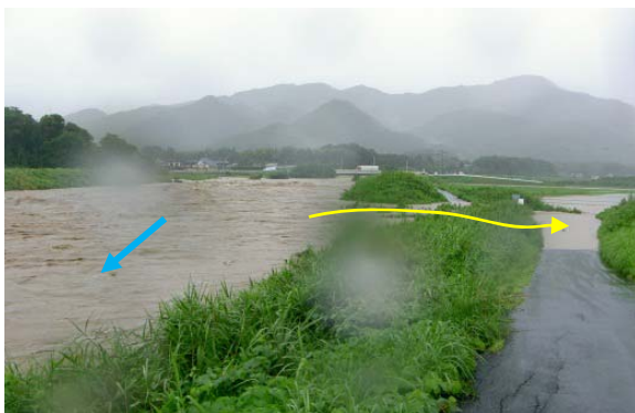
写真 2.2-28 4号野越しからの越水状況
