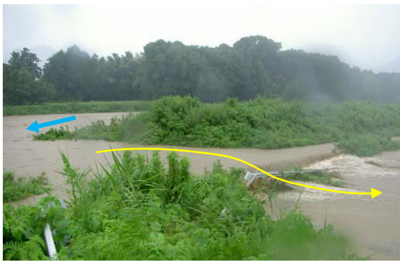
写真 2.2-27 3号野越しからの越水状況
