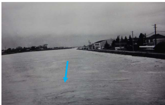
写真 2.2-14 下直島橋上流
