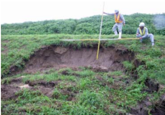
写真 2.3-7 平成 21 年 7 月洪水による堤防川裏法面の崩壊(L=80m)、堤防川裏法尻からの漏水
