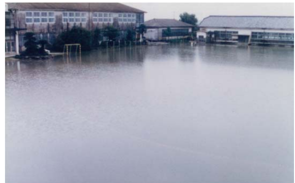
写真 2.2-21 城原川周辺の浸水状況
