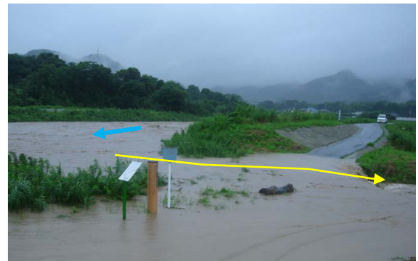
写真 2.2-37 4号野越しからの越水状況
