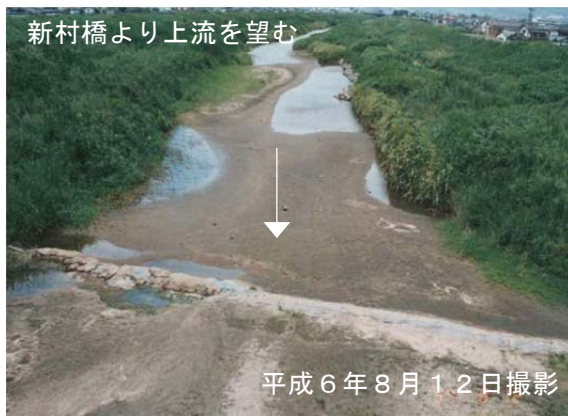
写真 2.2-46 渇水時状況写真
