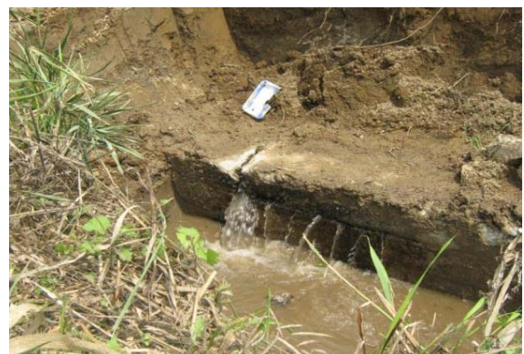
写真 2.3-8 樋管の状況、樋管函体からの漏水
