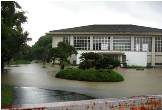
写真 2.2-30 神埼小学校の浸水状況
