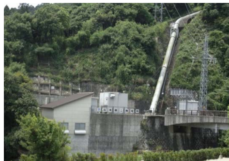
写真 2.2-42 広滝第二発電所
