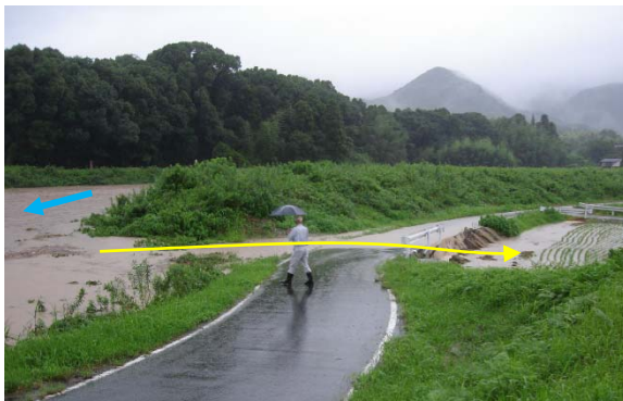
写真 2.2-36 3号野越しからの越水状況
