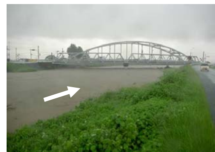
写真 2.3-1 平成21年7月洪水 (神埼橋付近)
