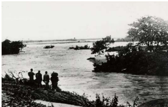
写真 2.2-5 城原川堤防決壊
