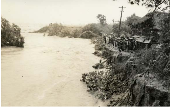
写真 2.2-7 城原川堤防決壊
