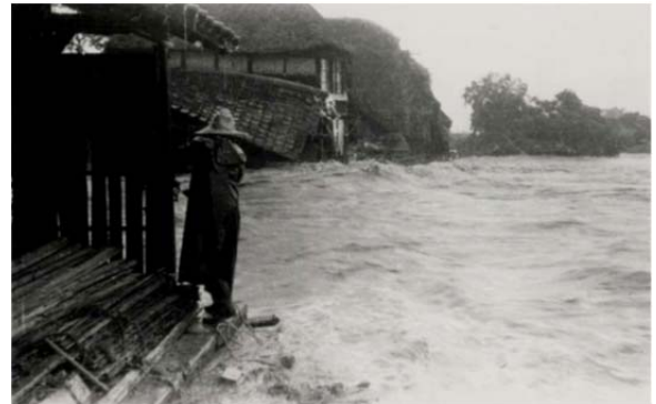
写真 2.2-10 城原川沿岸の民家流出
