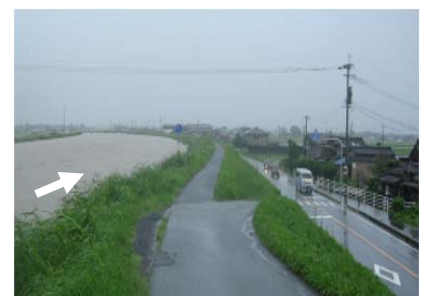
写真 2.3-2 平成22年7月洪水 (新村橋付近)
