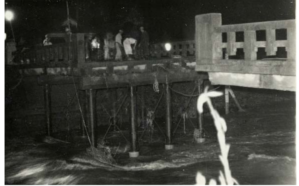
写真 2.2-8 城原川の橋梁流出
