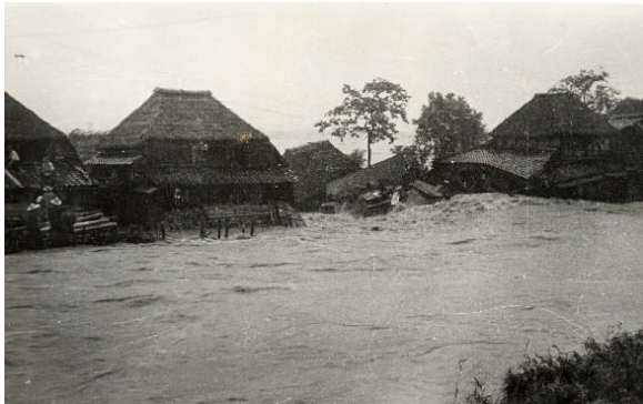
写真 2.2-9 城原川沿岸の民家流出
