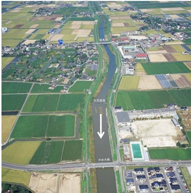
中央大橋付近 (2/800)
