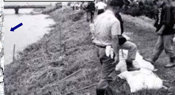
柴尾橋下流(1k600付近)
