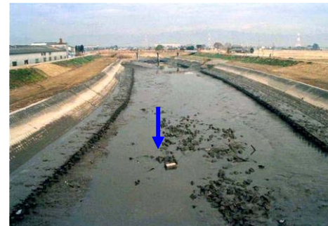
堂地大橋付近(0k200付近)の状況
