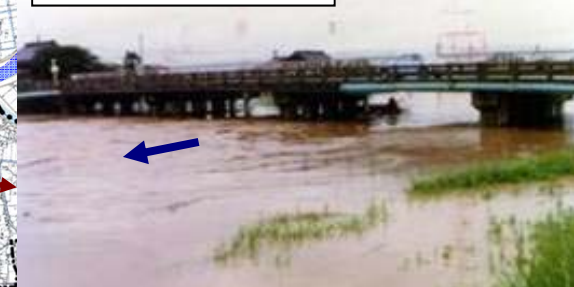
柴尾橋下流(1k600付近)
