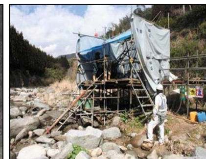
ボーリング調査
