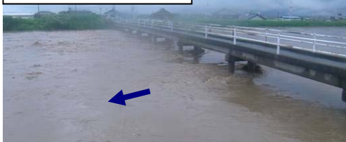
夫婦井樋橋下流(5k400付近)
