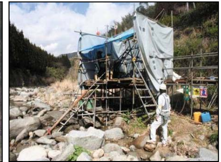
ボーリング調査
