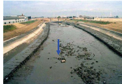
堂地大橋付近(0k200付近)の状況
