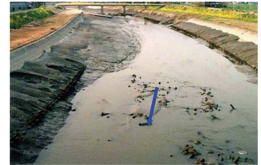
掘削後約3年3ヶ月 (平成4年3月)
