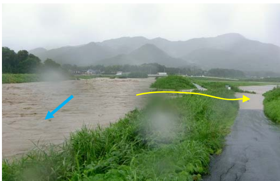
写真 2.2-28 4号野越しからの越水状況
