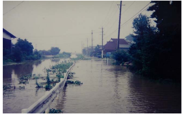
写真 2.2-23 馬場川の氾濫状況
