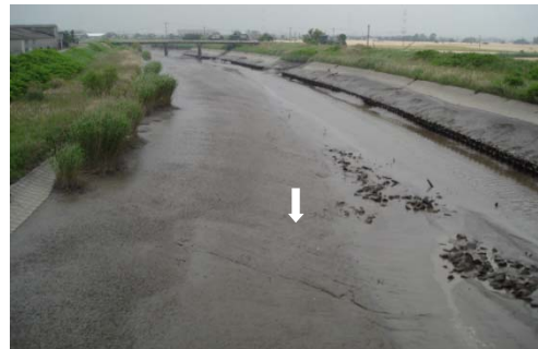
写真 2.1-22 堂地大橋より上流
