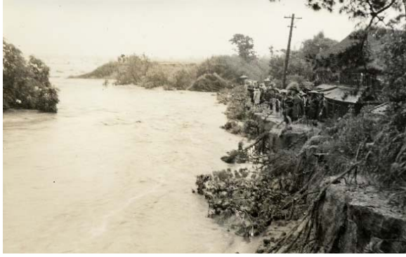
写真 2.2-7 城原川堤防決壊
