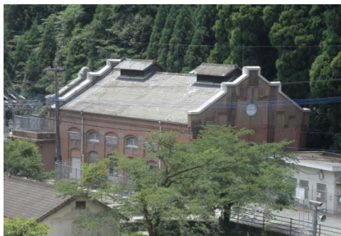
写真 2.2-41 広滝第一発電所
