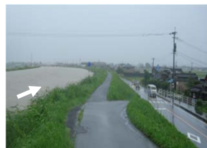
写真 2.3-2 平成22年7月洪水 (新村橋付近)
