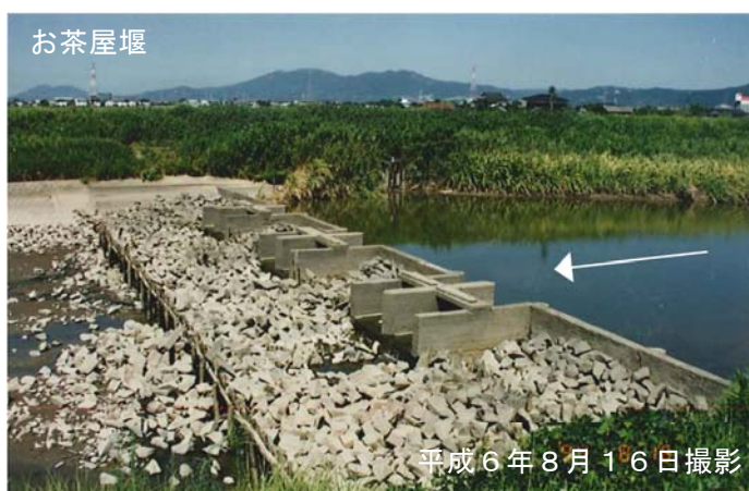
写真 2.2-48 渇水時状況写真
