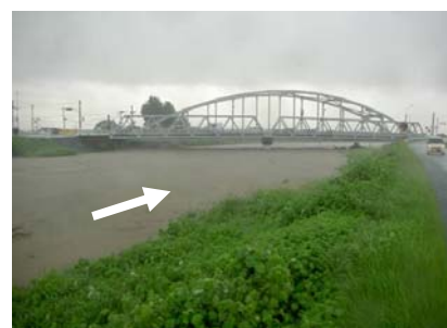
写真 2.3-1 平成21年7月洪水 (神埼橋付近)
