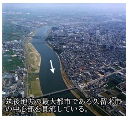
写真 2.1-10 久留米市周辺 (豆津橋付近)
