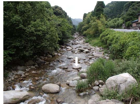
写真 2.1-15 向山橋より上流
