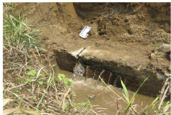
写真 2.3-8 樋管の状況、樋管函体からの漏水
