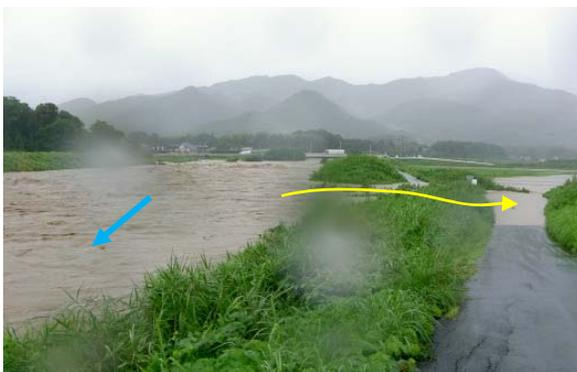
写真 2.2-28 4号野越しからの越水状況
