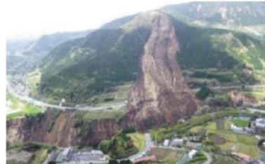
② 土砂災害の状況 (熊本県南阿蘇村)
