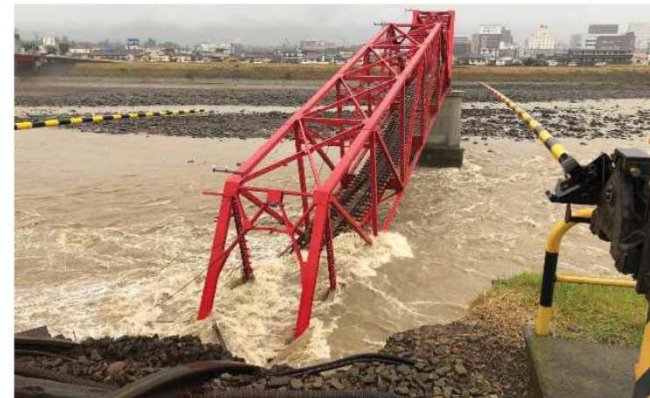
上田電鉄別所線(千曲川橋梁)
