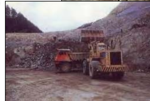
掘削工（他ダム事例）
