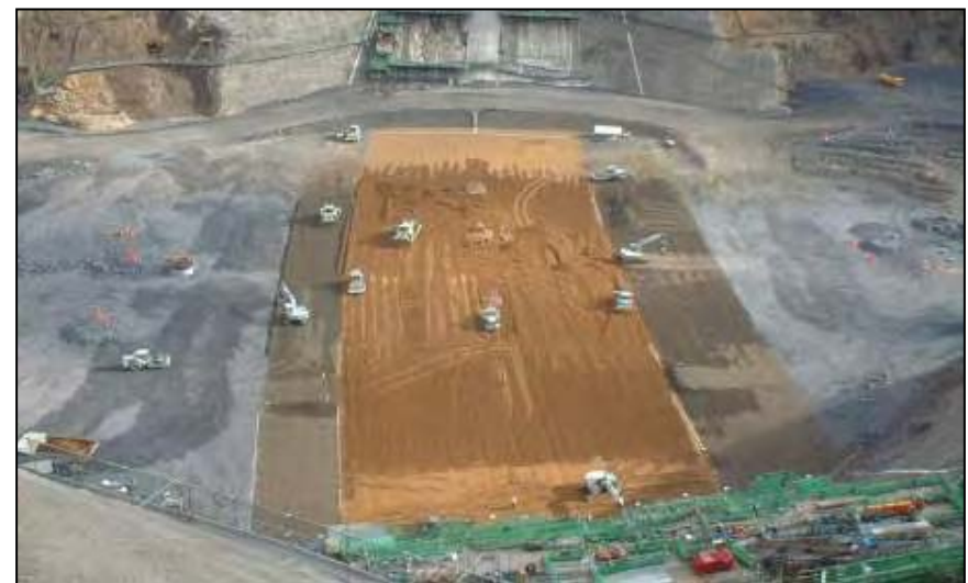
堤体工状況写真（他ダム事例）
