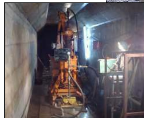
グラウチング状況（他ダム事例）
