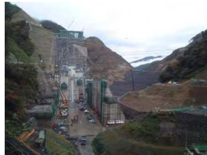
洪水吐き施工状況（他ダム事例）
