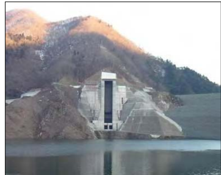
取水設備写真（他ダム事例）
