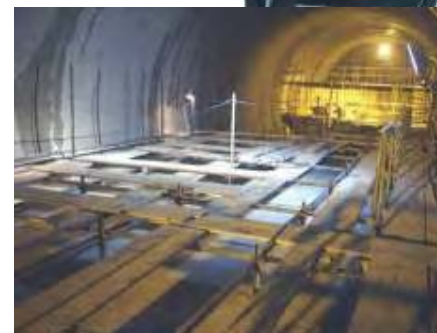
仮排水路トンネル閉塞状況写真（他ダム事例）
