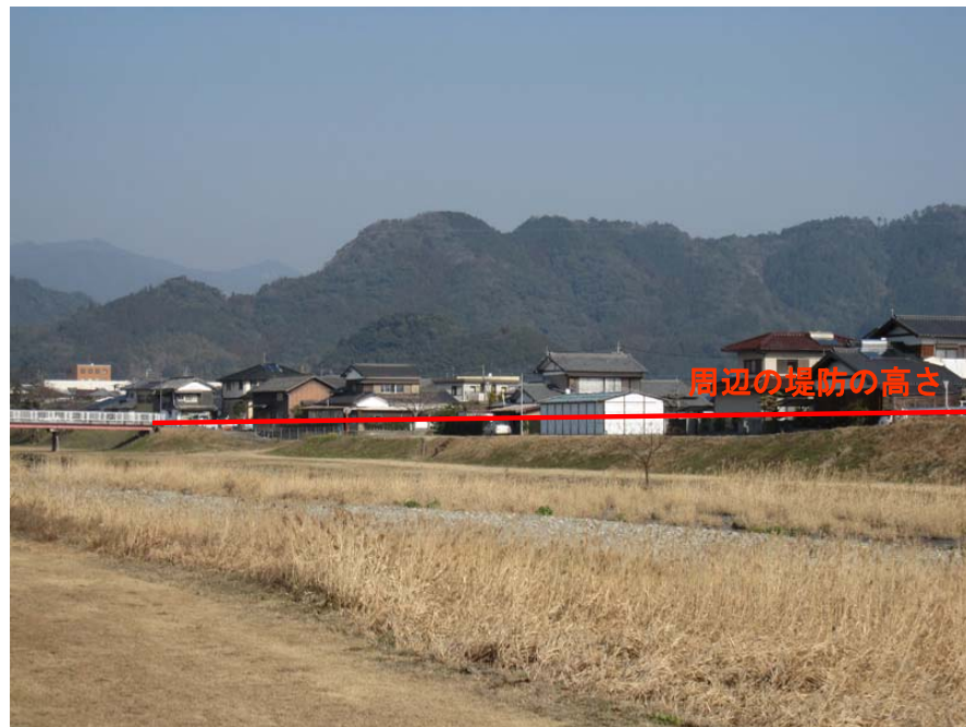
部分的に低くなっている堤防の例 (9K600付近)
