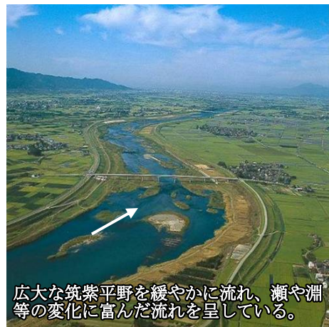
写真 2.1-10 筑後川の中流（朝羽大橋 あさは 付近）
