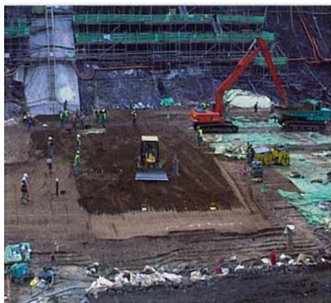
写真 2.3-1 ダムの堤体の工事の例
