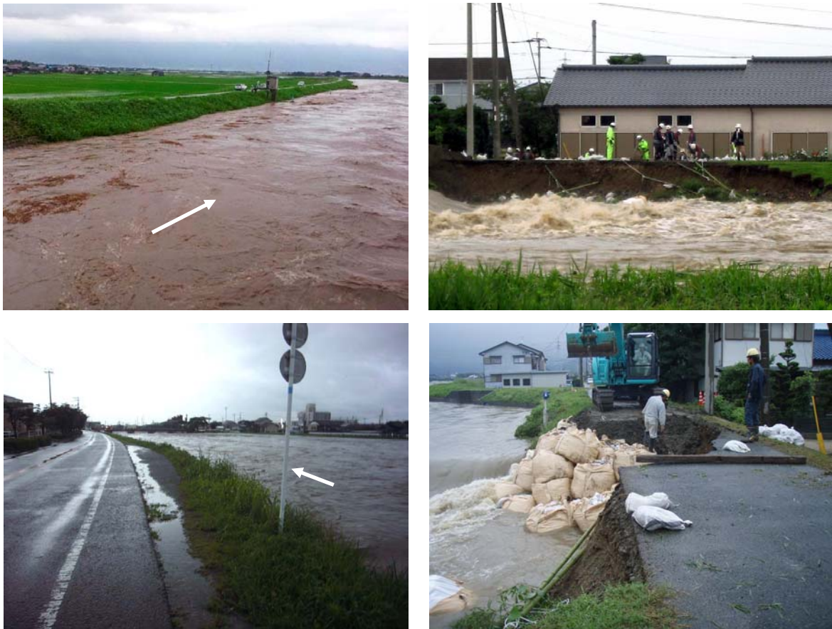
左上：栄田橋観測所の状況（6:50 頃） 左下：甘木橋上流の状況（6:00 頃） 右上：堤防の崩れに対する水防活動（竹流し・土のう積み） 右下：堤防の崩れに対する大型土のうによる応急対策状況 ※右上と同一箇所
