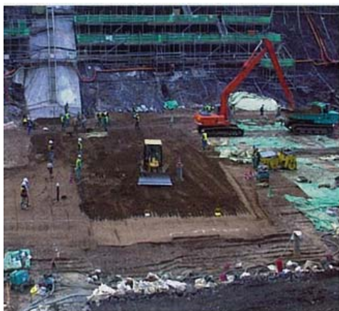
写真 2.3-1 ダムの堤体の工事の例
