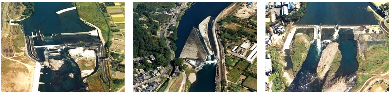
写真 2.2-4 筑後川中流の3堰（左から順に、恵利堰、山田堰、大石堰）
