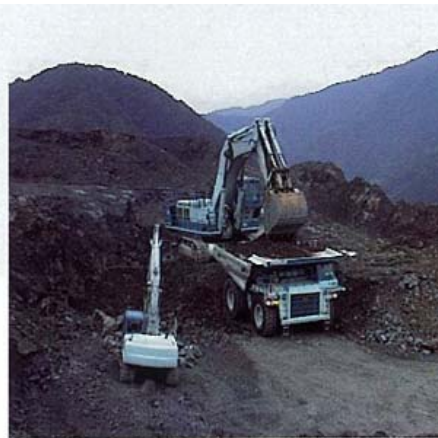
写真 2.3-2 原石の採取の工事の例
