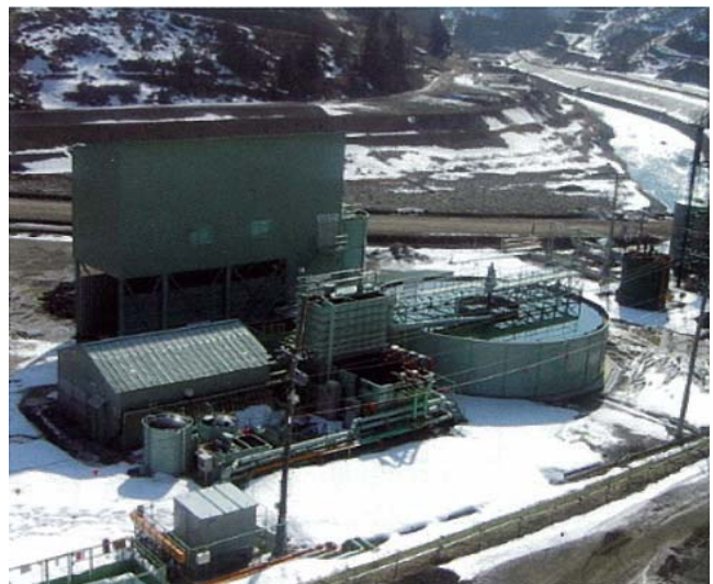
写真 2.4-1 濁水処理施設の例
