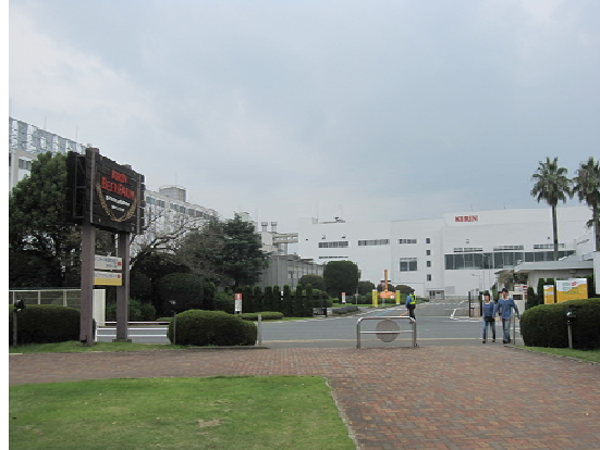
写真 2.1-6 ビール工場（朝倉市内）
