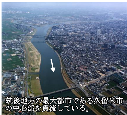
写真 2.1-11 久留米市周辺（豆津橋 まめづ 付近）
