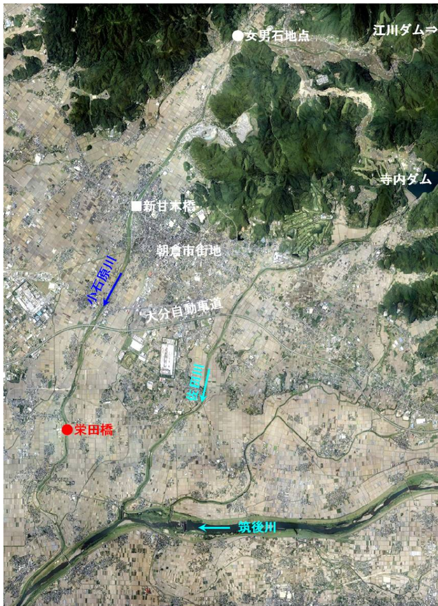
図 2.3-1 小石原川下流部の現状
