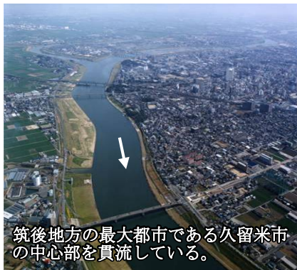
写真 2.1-11 久留米市周辺（豆津橋 まめづ 付近）
