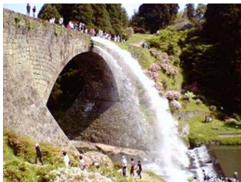
つうじゆんきょう 通潤橋
