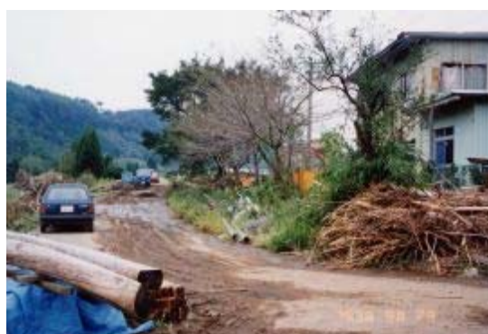
写真 2-2-2 平成5年9月洪水の被災状況 （七瀬川：大分市大字廻栖野）
