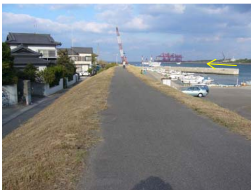
写真 2-3-1 高潮堤防状況 (大分市豊海)
