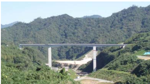
写真 3-3-3 河内橋 (仮称) (平成 24 年度完成予定)
