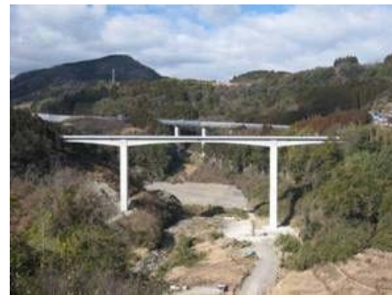
写真 3-3-2 付替市道尾原線 (平成 20 年 5 月完成)
