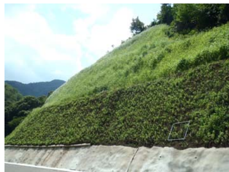
写真 3-2-4 種子吹付法面
