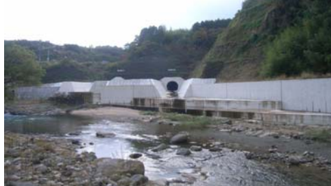
写真 3-3-4 仮排水路トンネル (平成 20 年 11 月完成)
