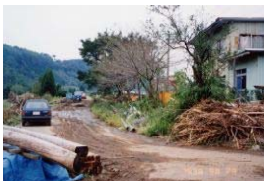
写真 2-2-2 平成5年9月洪水の被災状況 めぐすの (七瀬川：大分市大字廻栖野)
