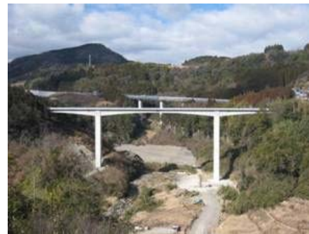
写真 3-3-2 付替市道尾原線 (平成 20 年 5 月完成)
