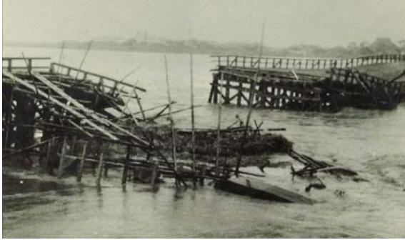
写真 2-2-3 昭和 28 年 6 月洪水 流失した舞鶴橋
