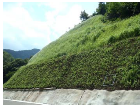
写真 3-2-4 種子吹付法面
