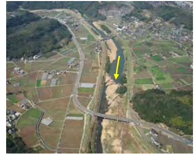
写真 2-3-12 七瀬川 (霊山橋付近)
