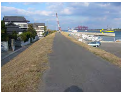
写真 2-3-1 高潮堤防状況 (大分市豊海)
