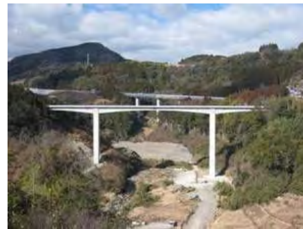
写真 3-3-2 付替市道尾原線 (平成 20 年 5 月完成)
