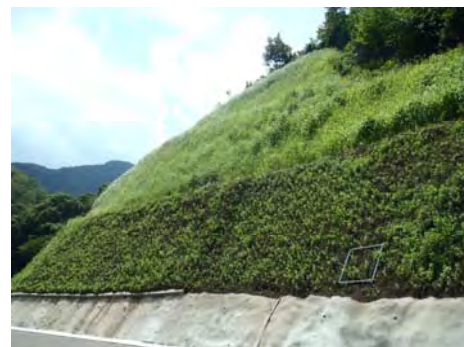
写真 3-2-4 種子吹付法面
