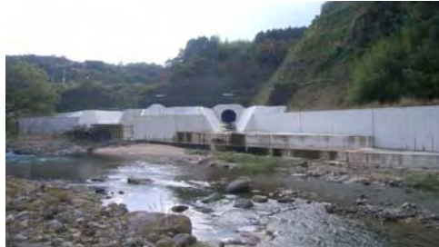
写真 3-3-4 仮排水路トンネル (平成 20 年 11 月完成)
