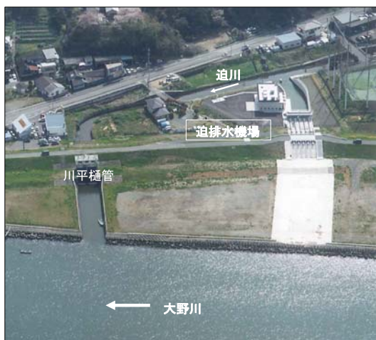
排水機場の実施例（大野川追排水機場）
