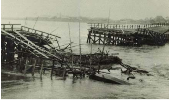
写真 2-2-3 昭和 28 年 6 月洪水 流失した舞鶴橋
