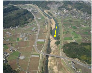
写真 2-3-12 七瀬川 (霊山橋付近)
