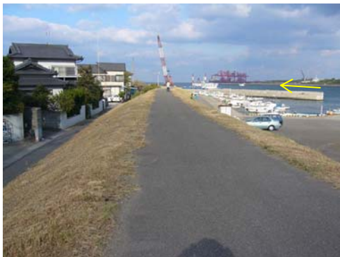
写真 2-3-1 高潮堤防状況 (大分市豊海)
