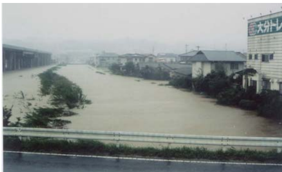
写真 2-2-7 平成 9 年 9 月洪水 尼ヶ瀬川の内水被害
