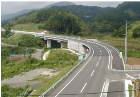
写真 3-3-1 付替国道 442 号 (平成 16 年 6 月完成)
