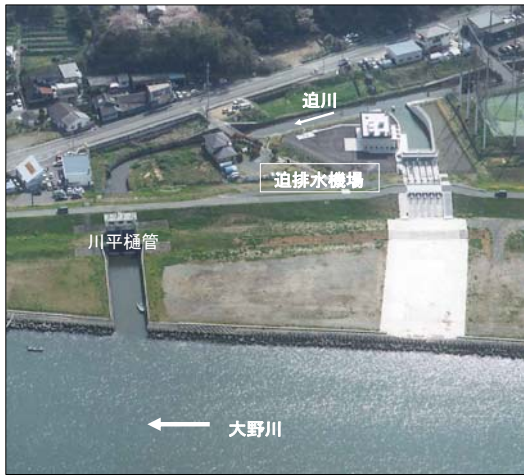
排水機場の実施例（大野川迫排水機場）
