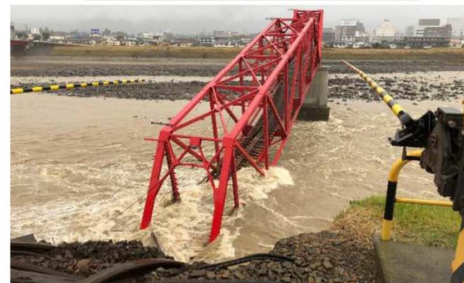
上田電鉄別所線(千曲川橋梁)
