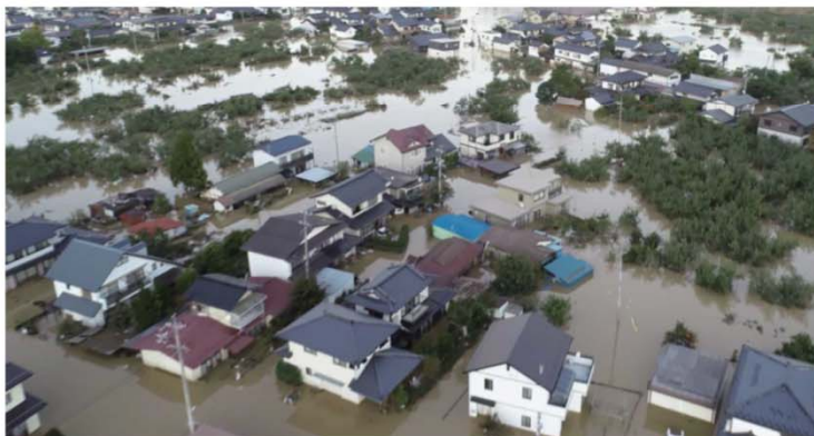
住宅等浸水状況(長野県長野市)
