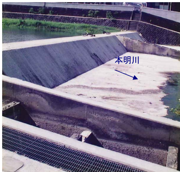
公園堰と魚道の状況 平成6年8月撮影
