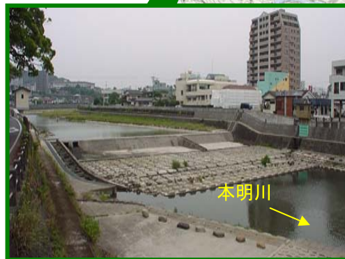
公園堰(本明川5k100付近)
