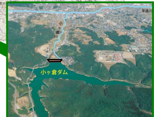
おがくら 小ヶ倉ダム
