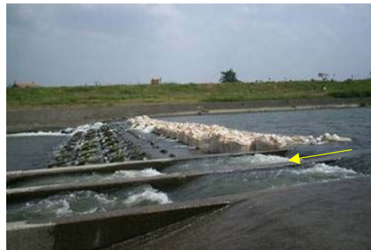
上水の取水のため土のうを積んだ 府内(ふない)堰(平成17年)
