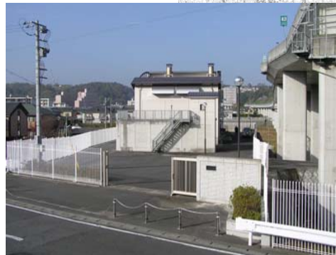
あまがせ 尼ヶ瀬排水ポンプ場（H13完成）
