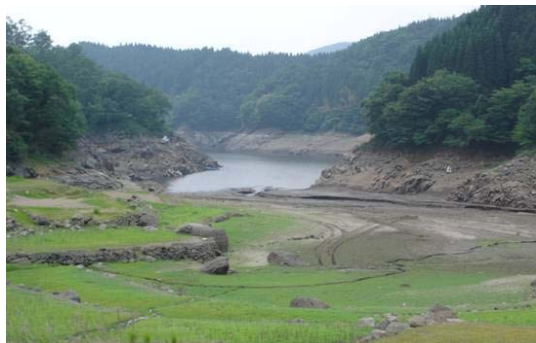
少雨のため水位が大きく低下した 芹川(せりかわ)ダム(平成17年)
