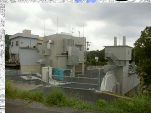
みやざき 宮崎排水ポンプ場（H19完成）
