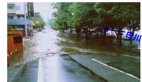
あんせい 安巳橋下流左岸の状況
