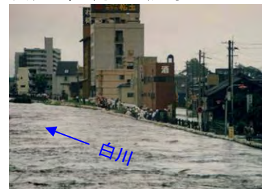
白川橋下流右岸の状況
