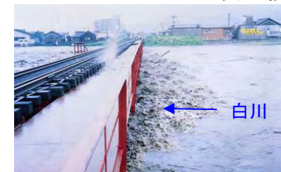
白川第一橋梁の状況
