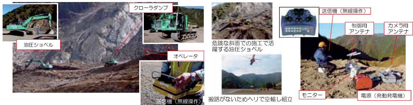
無人化施工の様子(赤谷)
