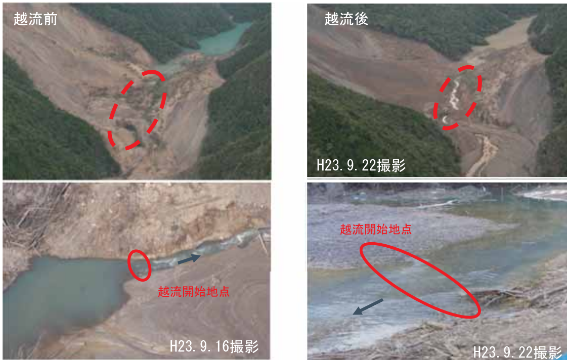
赤谷地区河道閉塞の越流前後の状況
