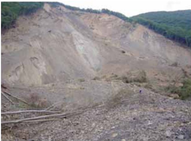
赤谷地区の被災状況 (H23. 9. 15)
