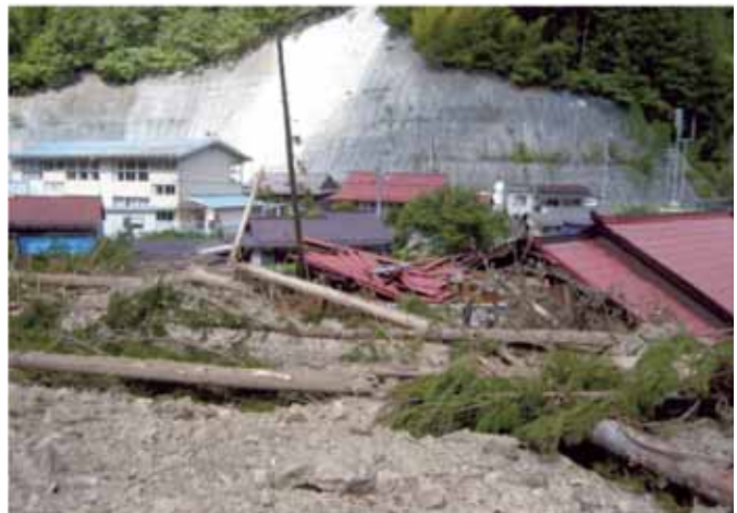
北股地区の被災状況 (H23. 9. 15)
