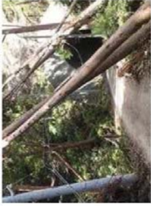
⑨電柱・倒木倒壊の状況 (千葉県鴨川市)
