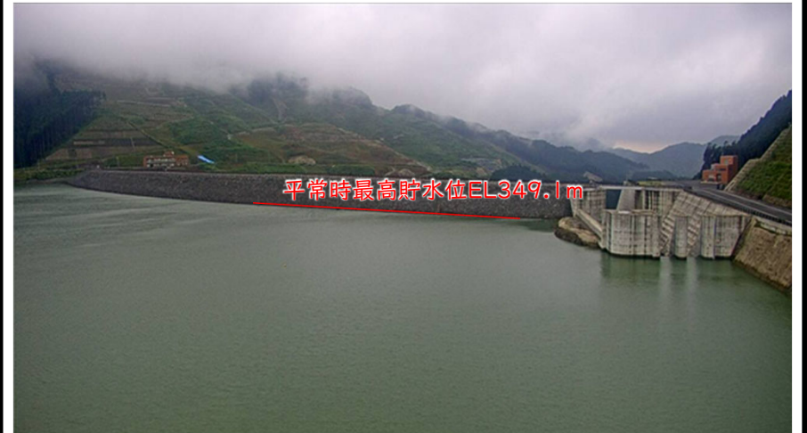
平常時最高貯水位付近の状況(R5.7.5:EL349.15m)
