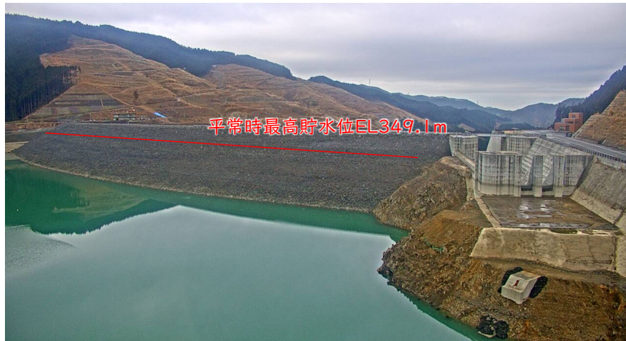
小石原川ダム現状(R6.2.15:EL330.39m)
