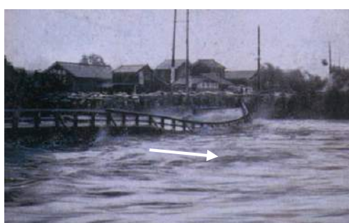
写真 2.2.1 流失直前のめいご橋
