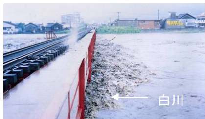
写真 2.2.8 第一白川橋梁地点の流下状況
