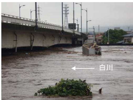
写真 2. 2. 12 蓮台寺橋地点の流下状況
