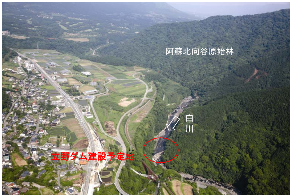
図 3-3 立野ダム予定地周辺の航空写真
