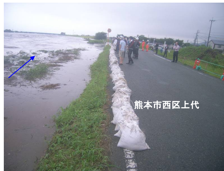
熊本西大橋下流右岸付近の状況 (7/12 11:01)
