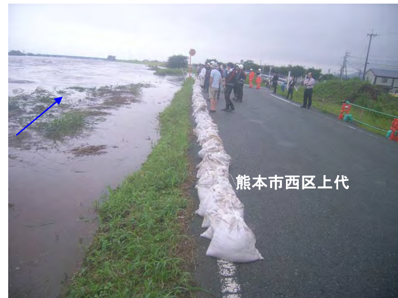
熊本西大橋下流右岸付近の状況 (7/12 11:01)
