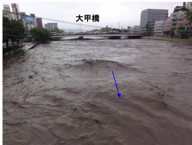
大甲橋下流の流下状況 (7/12 11:31)
