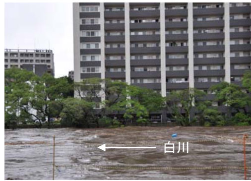
写真 2. 2. 11 大甲橋上流の流下状況
