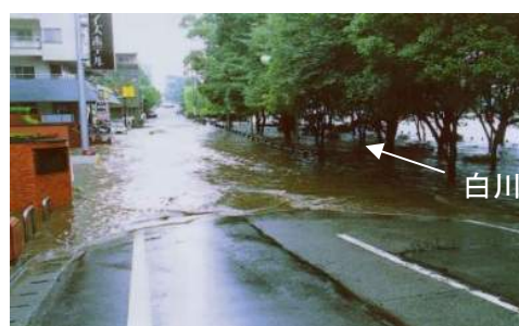
写真 2.2.7 安巳橋 あんせいでい 下流左岸の越水状況
