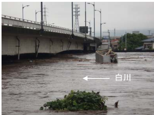
写真 2. 2. 12 蓮台寺橋地点の流下状況
