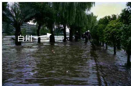
写真 2.2.5 熊本市 じょうとう 城東地区の越水状況
