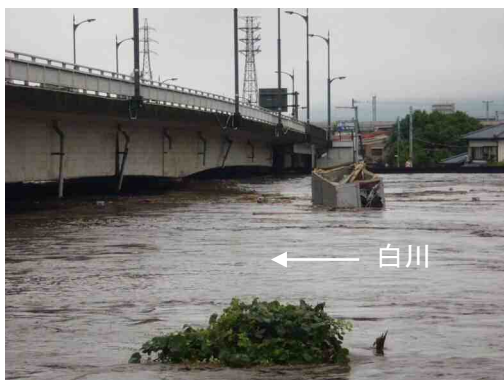
写真 2. 2. 12 蓮台寺橋地点の流下状況
