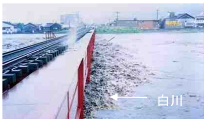
写真 2.2.8 第一白川橋梁地点の流下状況
