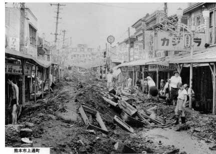
写真 2.2.2 洪水後のヨナの堆積状況(熊本市上 かみとお 通町)
