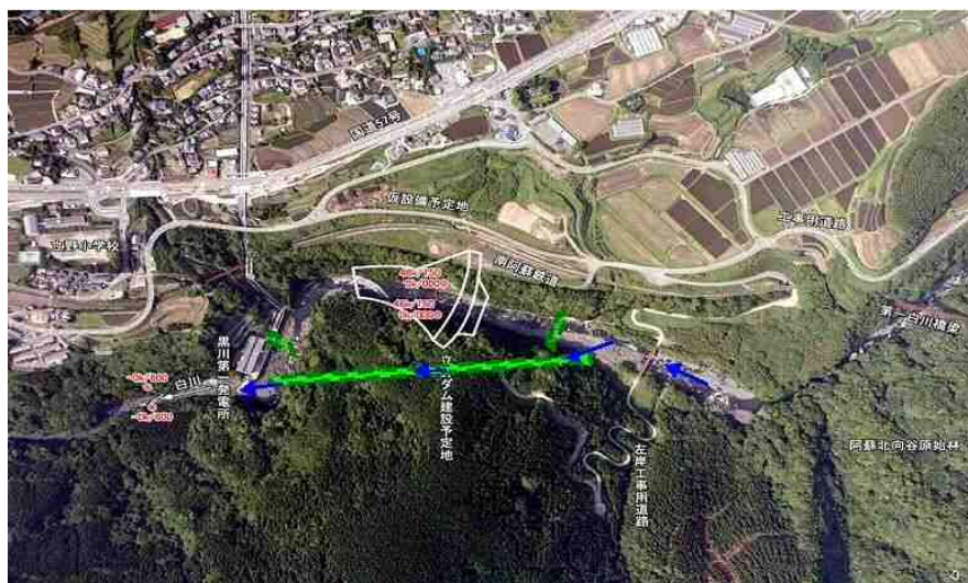
写真 3.1.1 立野ダム全体写真
