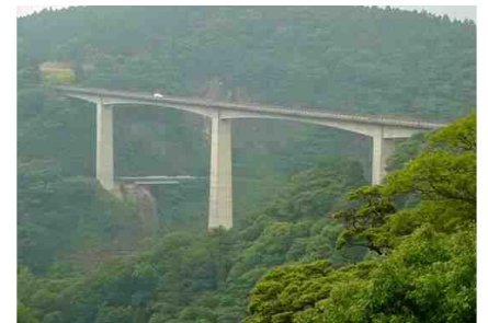
写真 3.3.1 阿蘇長陽大橋 (平成5年3月完成)
