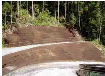
〈工事完成直後〉
