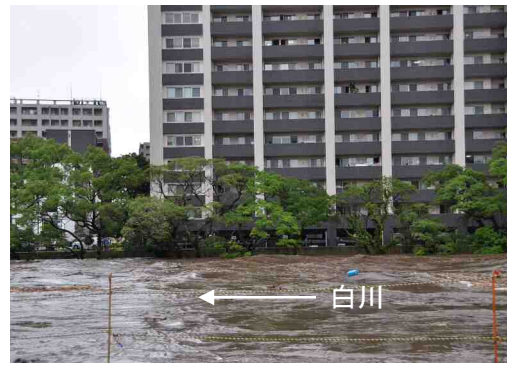
写真 2. 2. 11 大甲橋上流の流下状況
