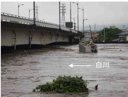
写真 2. 2. 12 蓮台寺橋地点の流下状況
