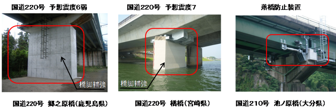
写真 1 九州内における耐震補強状況
