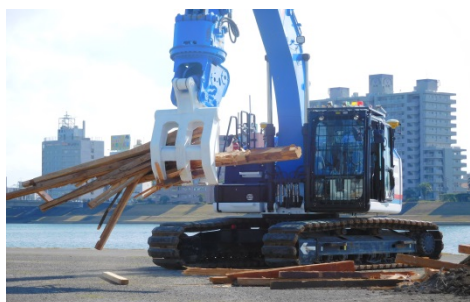
遠隔操作によるガレキ等撤去
