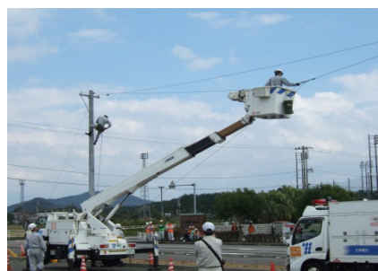
占用者（電力会社）によるケーブル敷設
