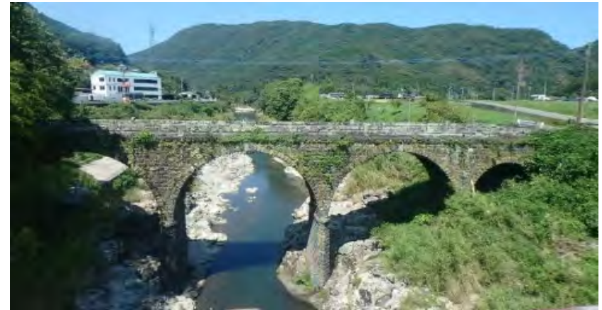
写真1.5-4 高い橋脚を有する多径間の事例
