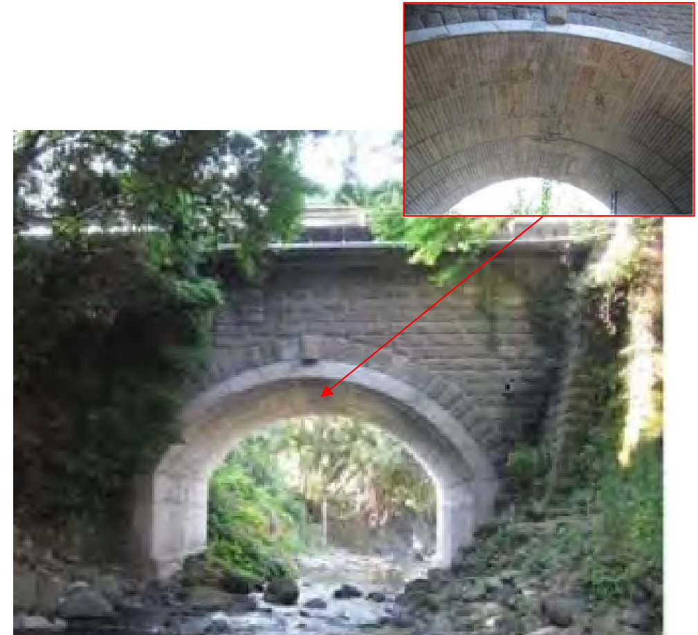
写真2.36-2 輪石全体を補強している事例
