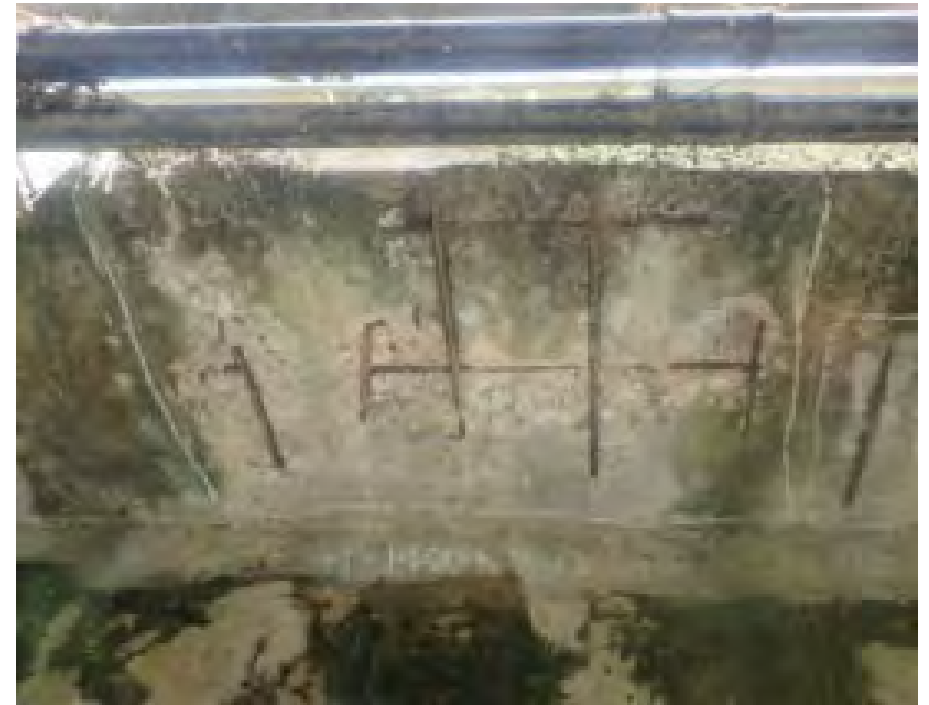
写真2.38-1 コンクリート床版で拡幅している事例
