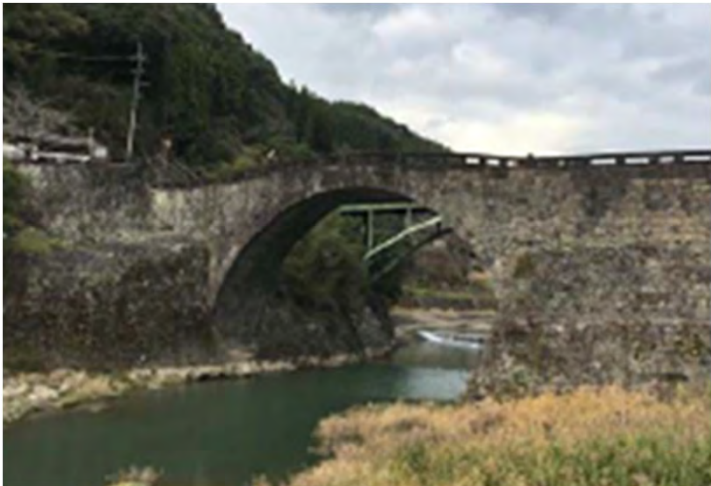
〔国指定〕 霊台橋(美里町)
