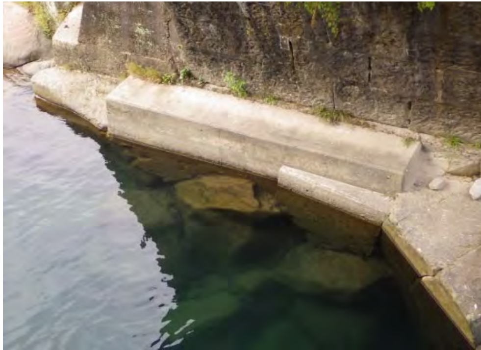
写真2.36-1 基礎部分を補強している事例
