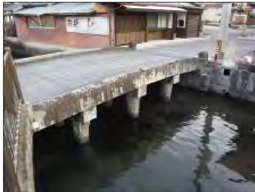
写真1.2-2 石桁橋の事例 [中の橋(佐賀市)]
