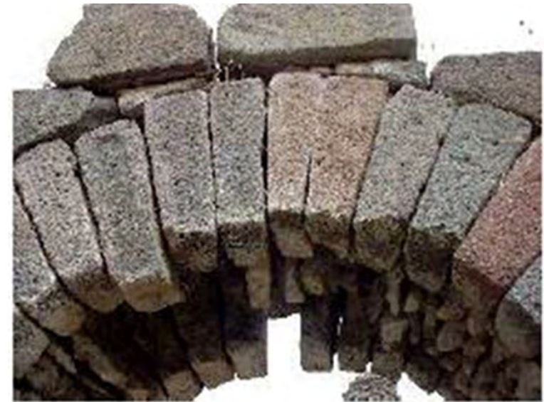
図2.6-2 実石橋の輪石の事例
