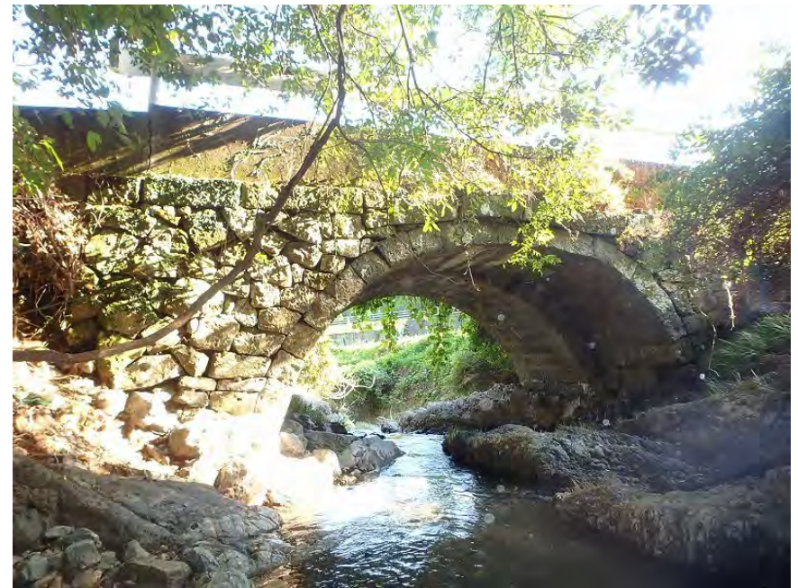
写真2.27-2 古殿橋(豊後大野市)[1817年竣工]
