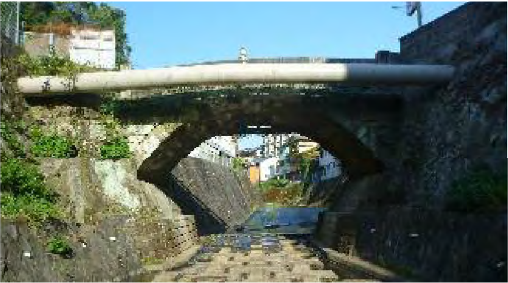
第2位 一の瀬橋(長崎市)
