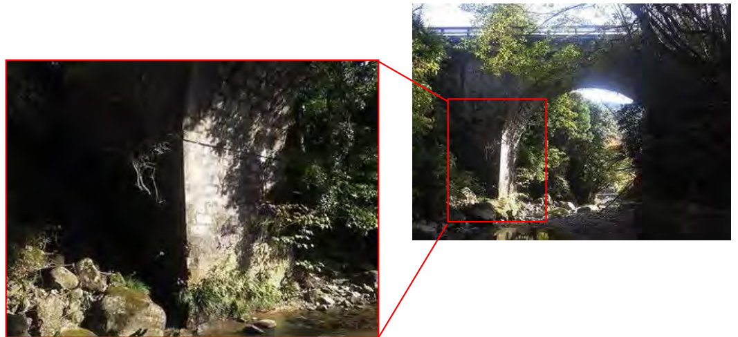
写真1.5-2 橋台を有する単径間の事例
