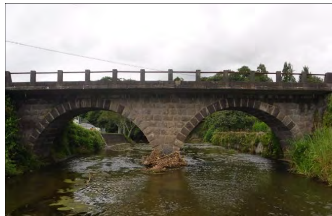
写真1.2-1 石造アーチ橋の事例 [久保橋(臼杵市)]
