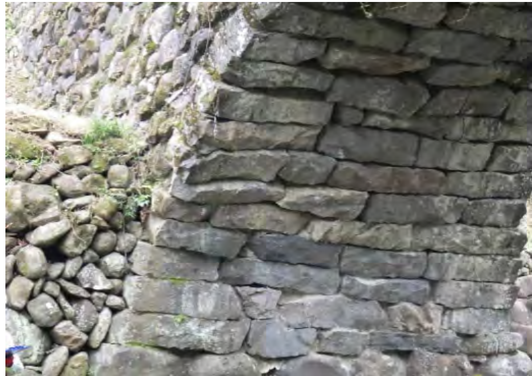
写真2.31-2 自然石を積み上げた事例
