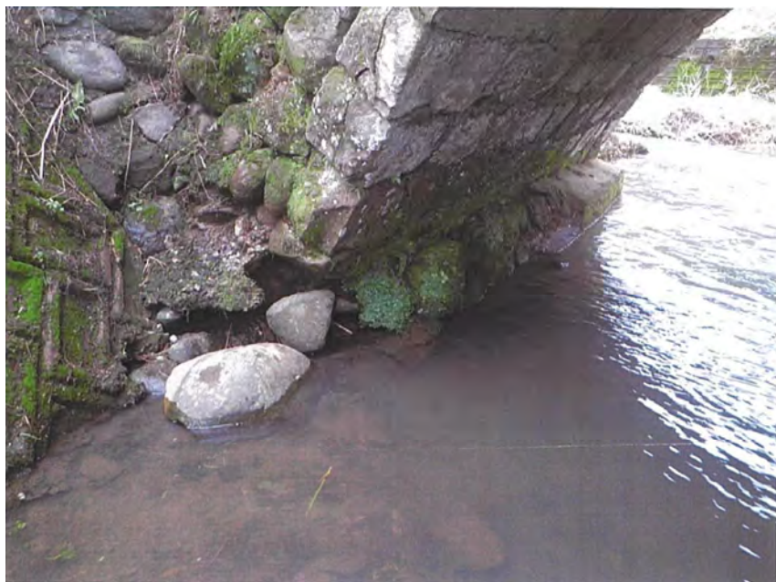
写真1.10-1 舗装の異常(背面地盤の沈下)と基礎の洗掘が確認された事例
