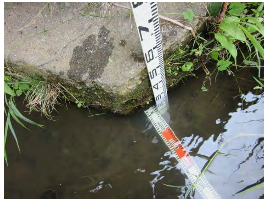
写真1.10-1 舗装の異常(背面地盤の沈下)と基礎の洗掘が確認された事例
