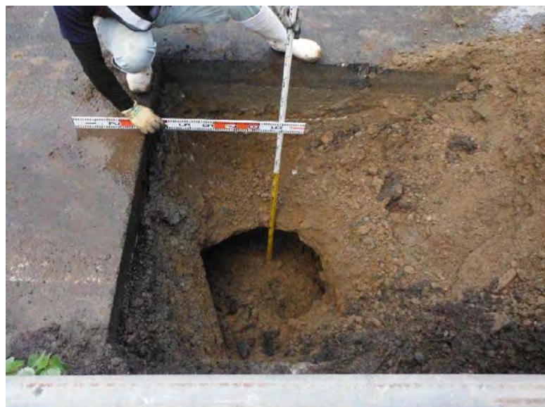
写真1.18-1 中詰土の流出による空洞の事例
