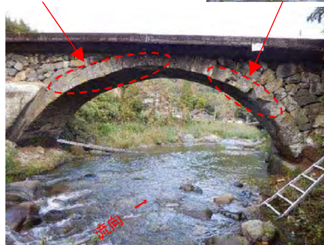
写真1.11-1 アーチ形状の変形の事例
