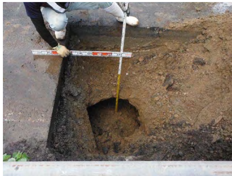
写真1.22-1 道路排水の滞水の事例（水の浸入により中詰土が流出して空洞が発生）
