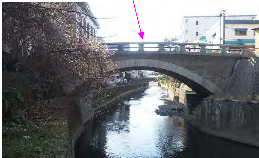
写真1.8-1 全体外観確認の事例①
