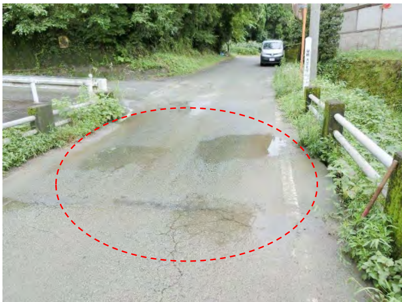
写真1.22-1 道路排水の滞水の事例（水の浸入により中詰土が流出して空洞が発生）
