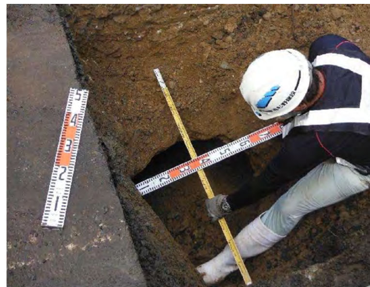
写真1.18-1 中詰土の流出による空洞の事例
