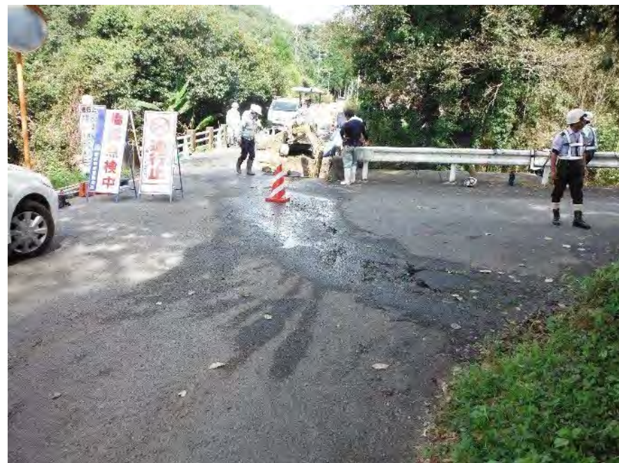
図1. 20-1 舗装・背面地盤の変状事例 写真1. 20-1 橋梁背面から水が流入した事例
