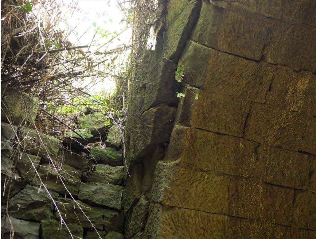
写真2.31-1 はらみ出しによる抜け落ちの事例①
