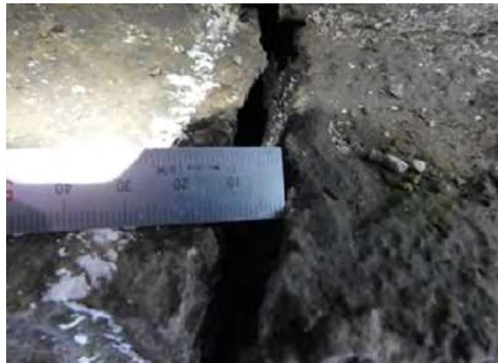
写真2.8-3 橋台のひびわれの発生事例(15mm程度)
