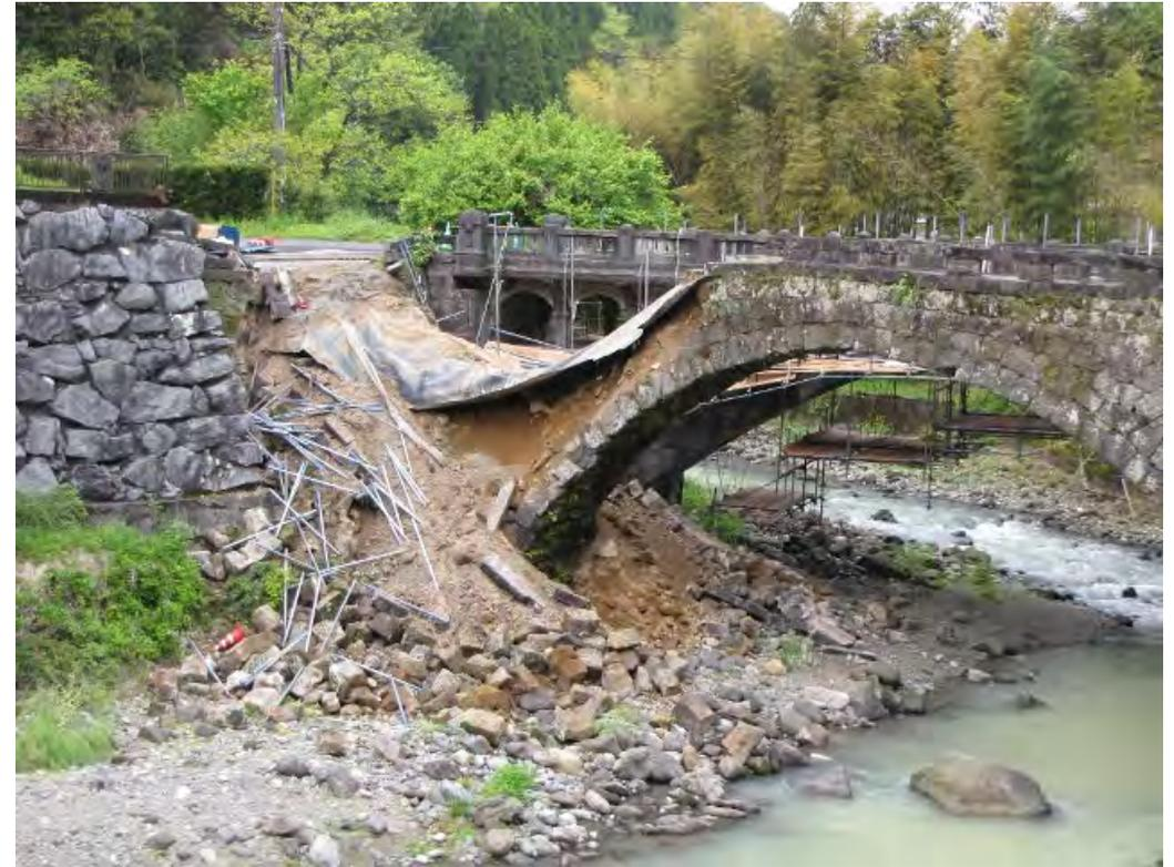
写真2.30-1 全面崩壊して中詰が流出した事例① 写真2.30-2 全面崩壊して中詰が流出した事例②
