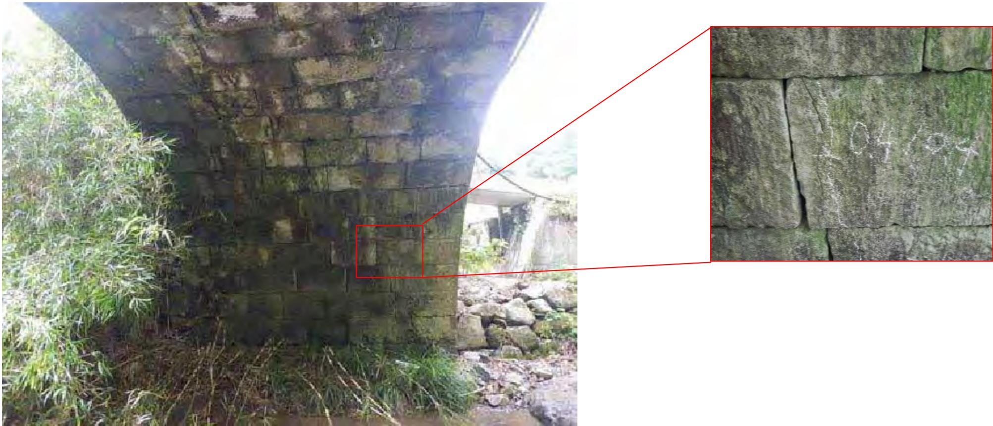
写真2.25-1 輪石のひびわれの事例
