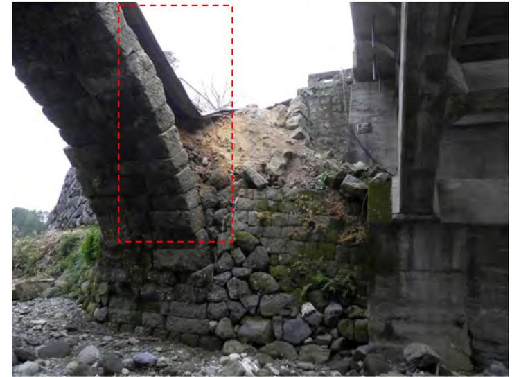
写真2.32-1 壁石抜け落ちて崩壊した事例
