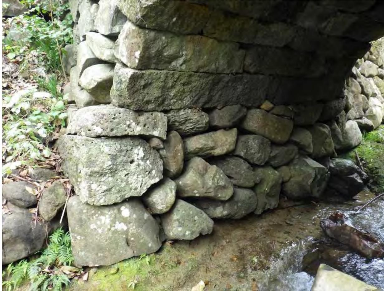
写真2.12-1 橋台下部に局部的に洗掘がみられる事例
