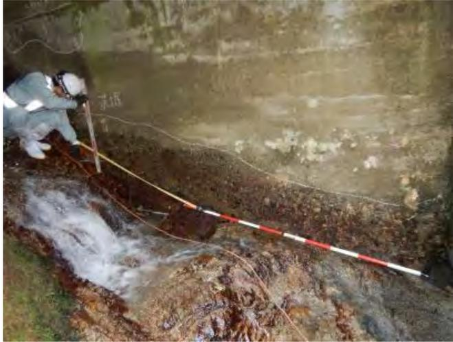
写真2.9-1 【A橋】支持地盤の流出事例
