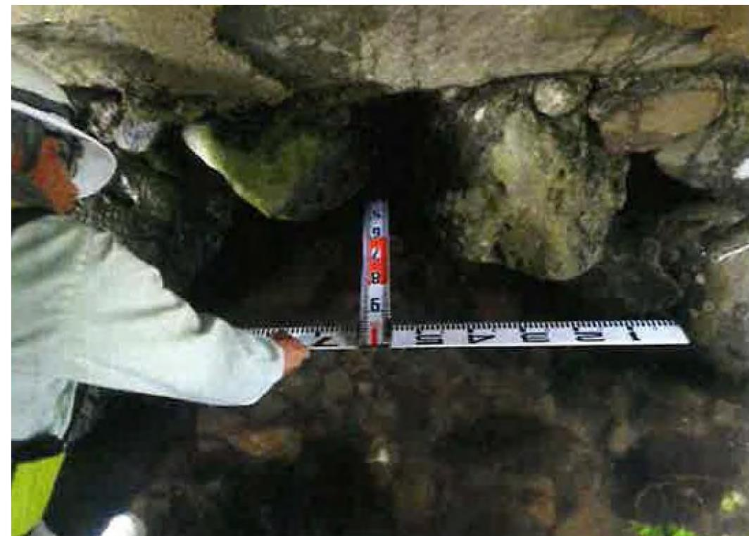
写真2.7-2 洗掘状況・背面状況の確認
