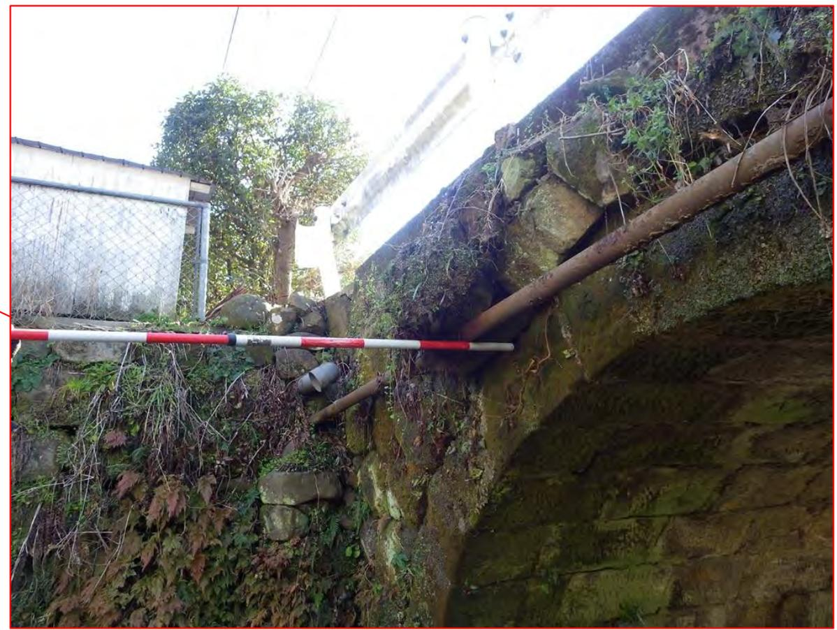
写真2.34-1 壁石の天端付近に部分的なはらみ出しの事例
