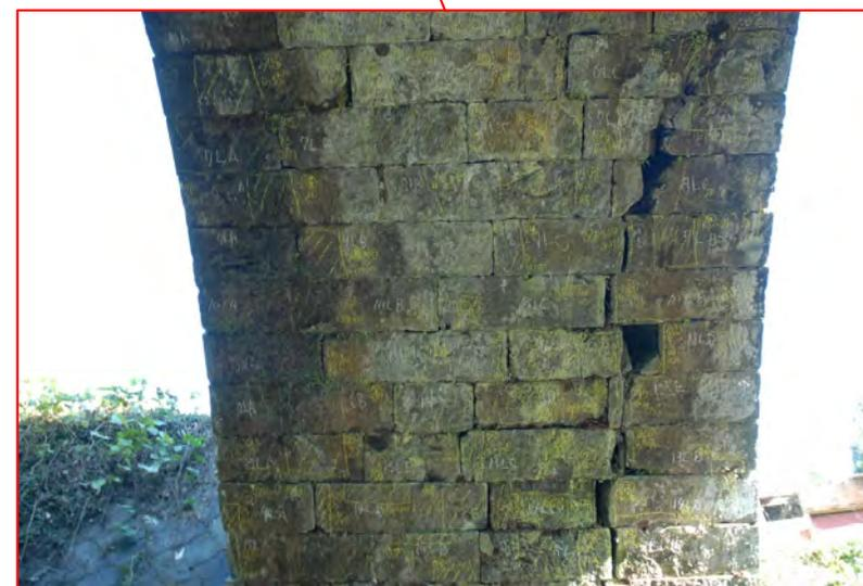
写真2.19-1 輪石の連続的な破断（亀裂）・抜け落ちの事例
