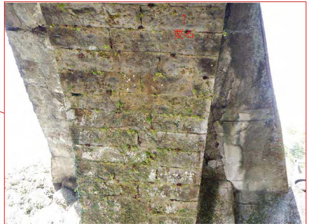
写真2.26-1 輪石の変色・劣化の事例
