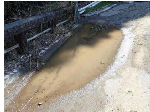
写真2.33-2 直上の路面に滞水
