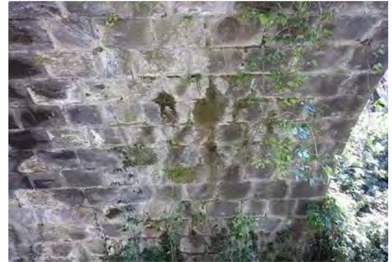
（舗装の異常の直下に漏水及び植生が見られる）
