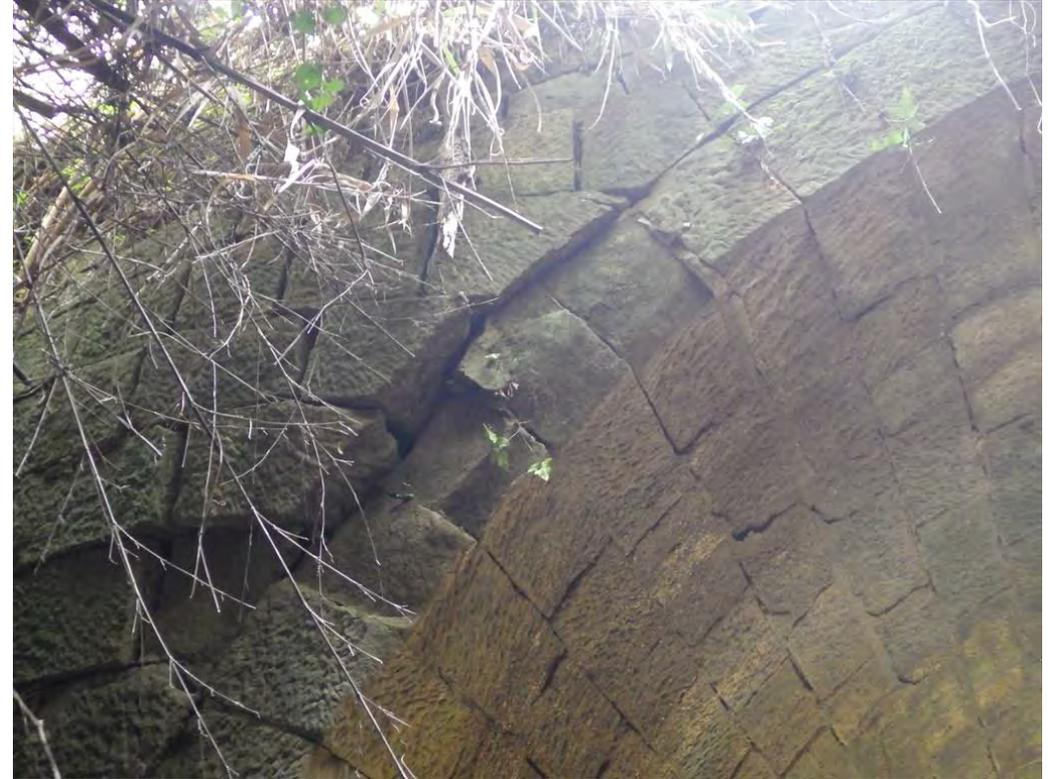
写真2.31-2 はらみ出しによる抜け落ちの事例②
