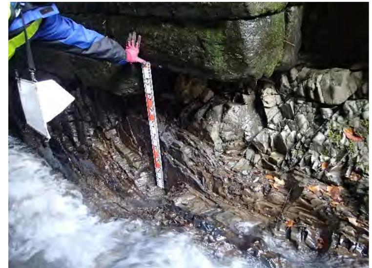
写真2.15-1 急流箇所での洗掘の事例
