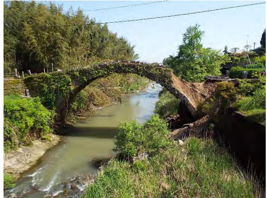
写真2.29-2 壁石が抜け落ちて崩壊した事例
