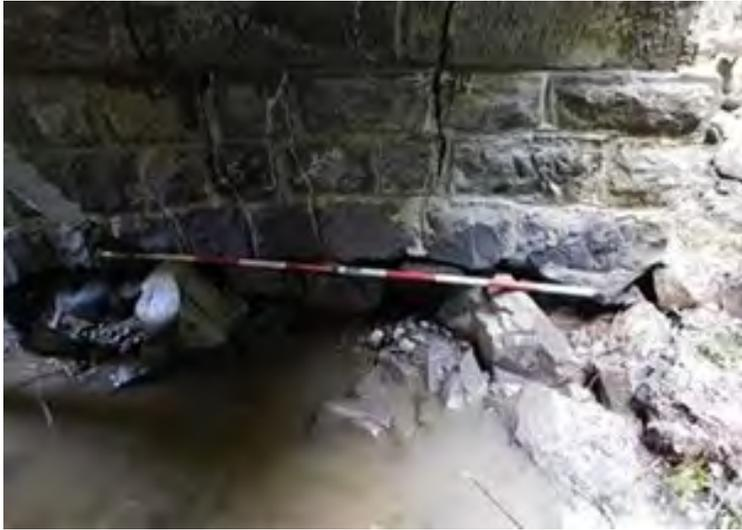
写真2.8-1 洗掘による橋台のひびわれの発生事例
