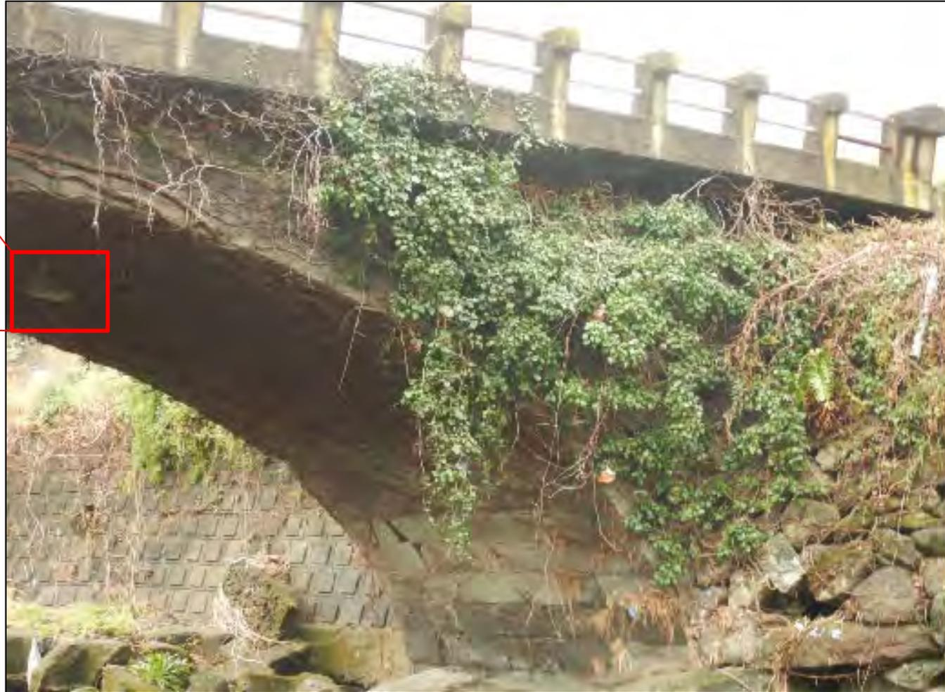
写真2.20-1 輪石のずれ（抜け出し）の事例
