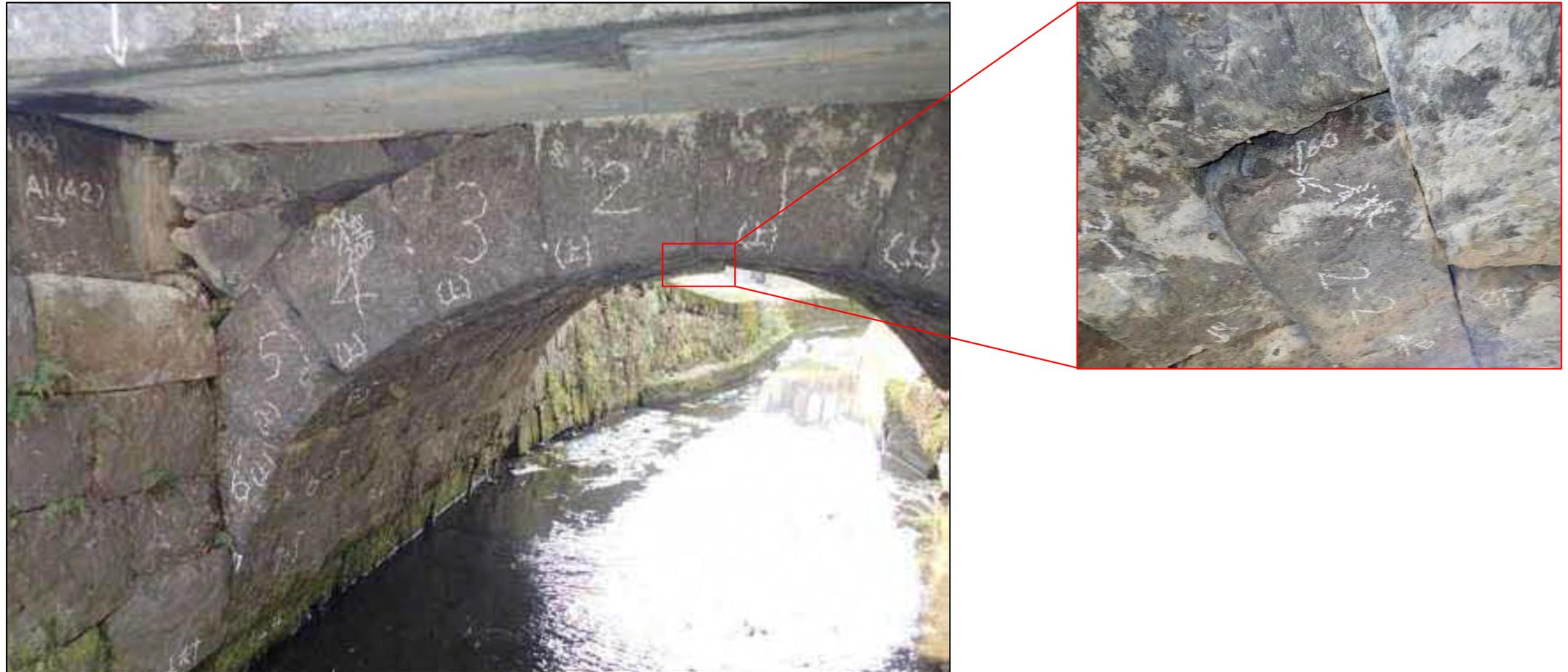
写真2.21-1 輪石のずれ（抜け出し）の事例
