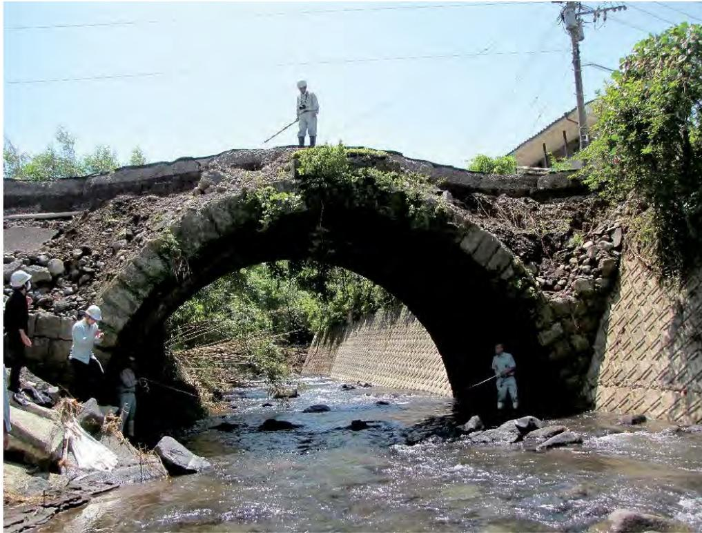
写真2.29-1 壁石の片面が抜け落ちて崩壊した事例
