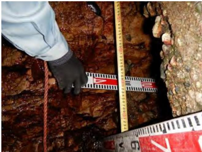
写真2.9-2 【A橋】支持地盤の流出事例(近景)
