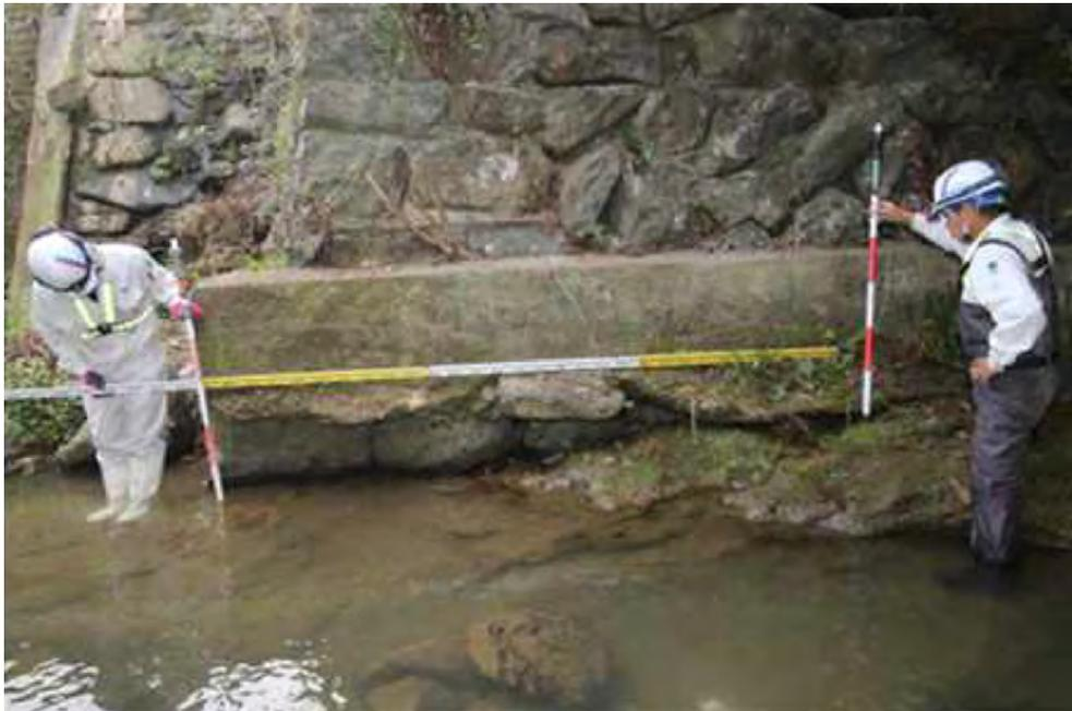
写真2.14-1 洗掘の計測状況①
