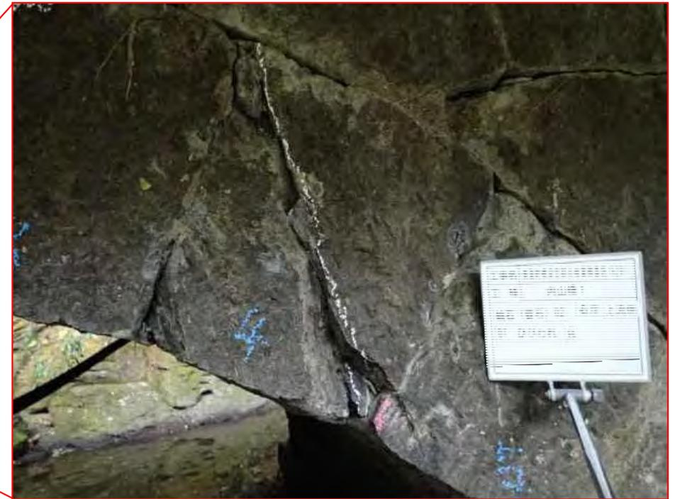
写真2.17-1 輪石側面部に斜方向の破断（亀裂）の事例
