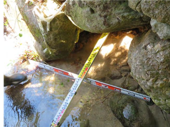
写真2.9-3 【B橋】背面土の流出状況の計測事例
