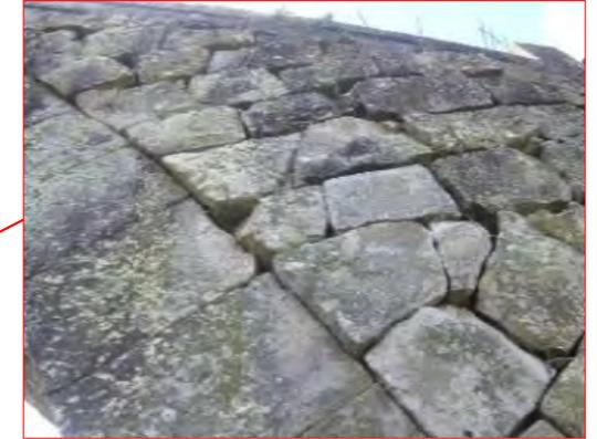
写真2.4-1 壁石面にはらみ出しが生じた事例
