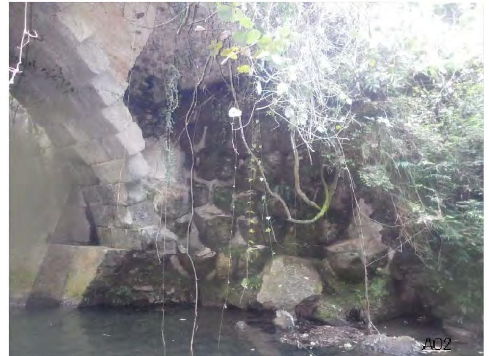
写真2.10-1 洗掘による崩壊の事例
