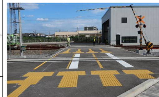
本実験の誘導表示等の敷設状況
